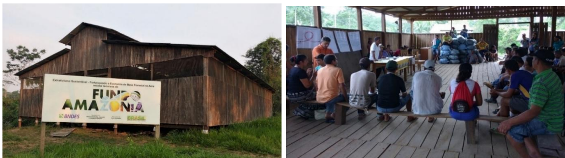
Figura 20 e 21 - Galpão de Armazenamento de castanha- colocação Chora Menino Fonte: Própria Autora
