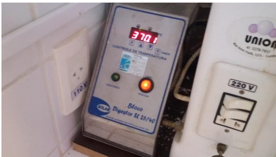
Figura 09. Parte externa do Bloco Digestor operando a 370°C. Foto: Marcus Vale.
