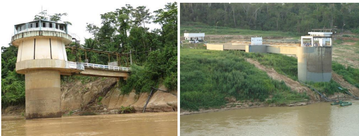
Figura 1 – Torres de Captação de água da ETA I e ETA II Fonte: autor
