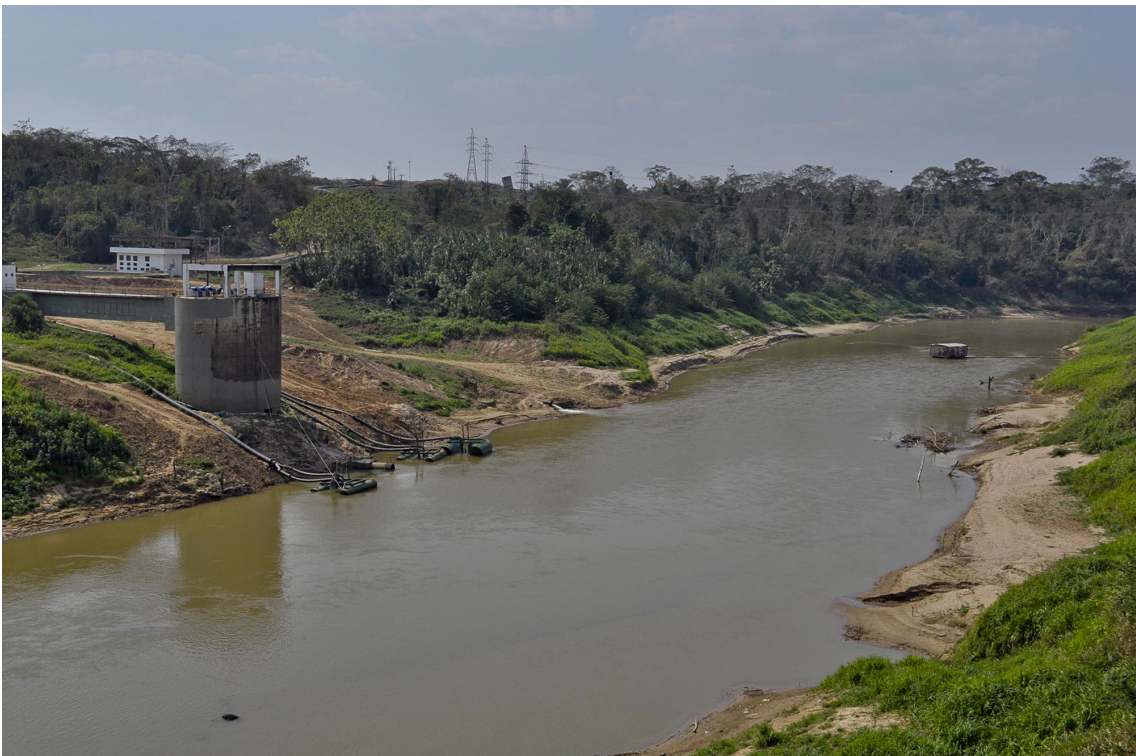
Figura 5: Torre de captação de água no rio Acre – ETA II.
