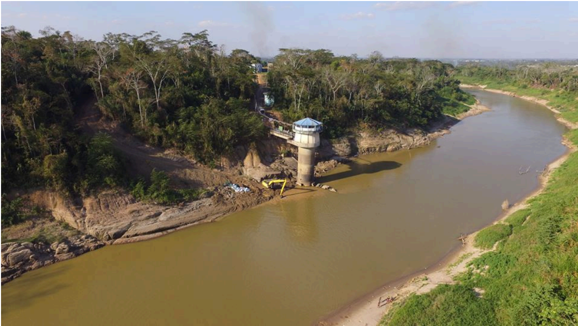
Figura 4: Torre de captação de água no rio Acre – ETA I.
