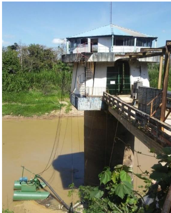
Figura 17 - Captação da Estação de Tratamento 1 mostrando duas formas de captação de água do Rio Acre
