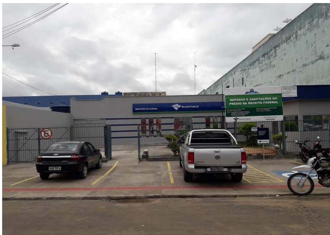
Foto 1: Vista frontal da IRF/CZL.
