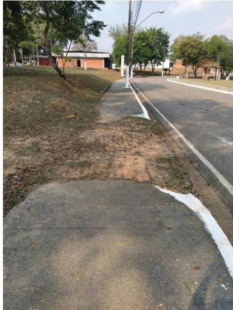
Figura 2 – Único Trecho existente em passeio de tijolo cerâmico (os demais estão em acabamento de concreto).
