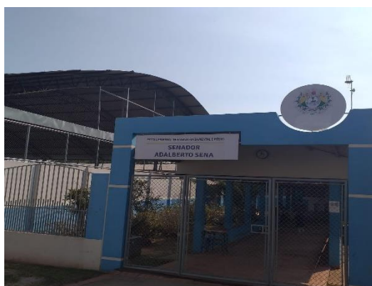
Figura 01 - Faixada da escola
