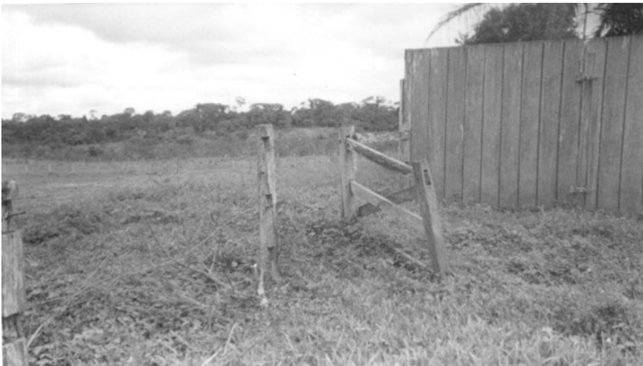
Jan. 2000. Fonte: Acervo da pesquisa. Cerca ao redor da Casa Sede - deteriorada
