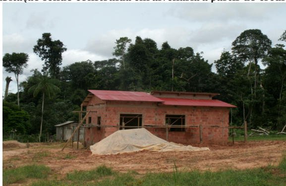
Foto 08. Habitação sendo construída em alvenaria a partir do crédito habitação
