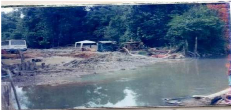
Fonte: Comissão Pastoral da Terra Escavação para os Minerodutos
