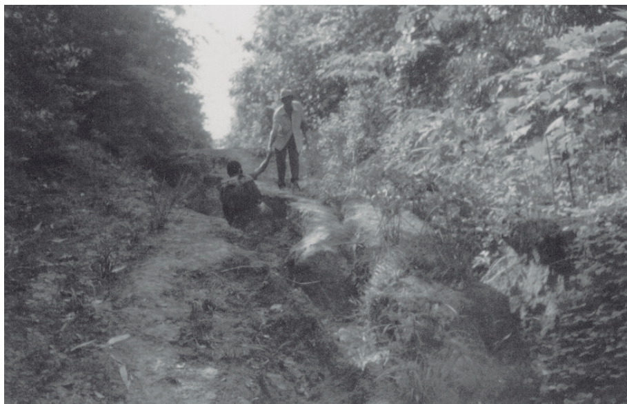
Imagem 10 – Condições intrafegáveis no ramal de acesso ao PAD
