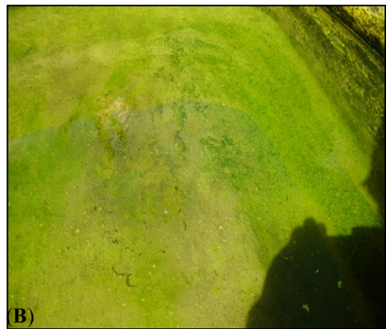
Figura 4. Reservatório com capacidade de 1 m 3 utilizada para armazenamento da água utilizada para a irrigação (A) e presença de lodo no interior do reservatório (B) na comunidade “Pé da Terra”, 2013.
