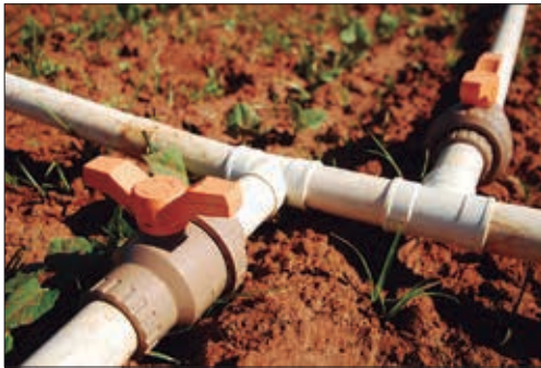
Figura 8 – Linhas laterais, dotadas de registro plástico de esfera, instaladas em conexões tês ao longo da linha de derivação
