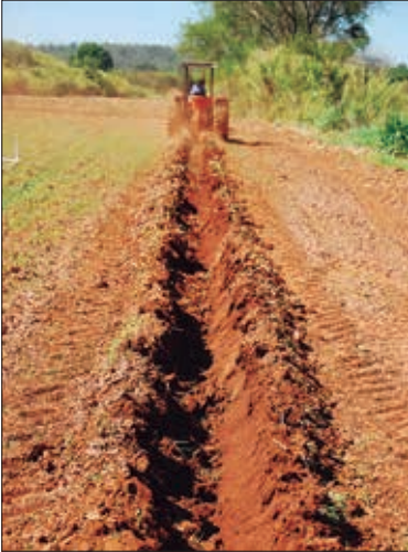
Figura 4 – Abertura de sulco para instalação da tubulação a uma profundidade suficiente para não correr riscos de impactos de implementos agrícolas
