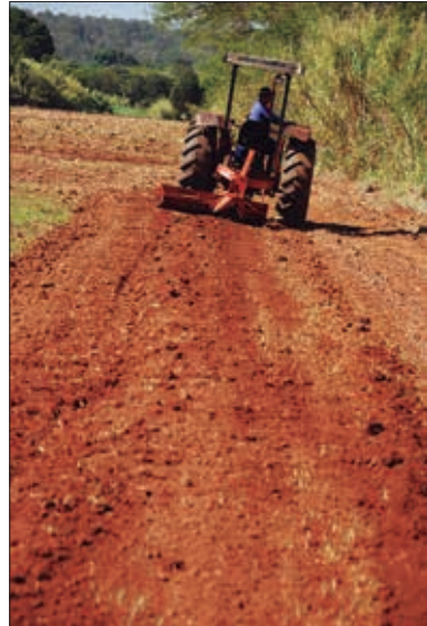
Figura 7 – Recobrimento da tubulação no sulco usando plaina traseira tracionada
