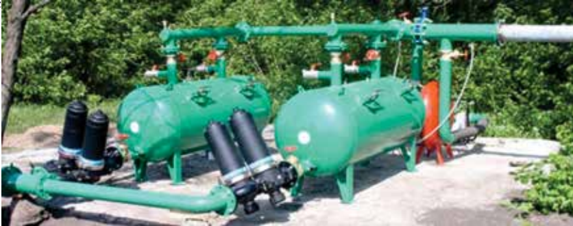
Figura 10.1 - Cabeçal de controle com filtros de areia e tela.
