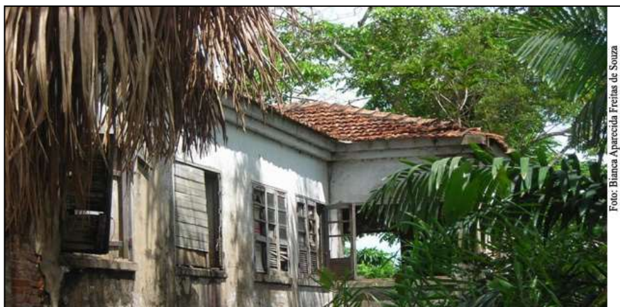
Figura 3 - Colônia Souza Araújo: Cozinha e o refeitório. Vista lateral. Construído na década de 50.
