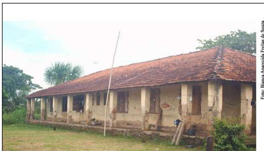
Figura 2 - Colônia Souza Araújo: Pavilhão com quatorze quartos. Construído na década de 50.
