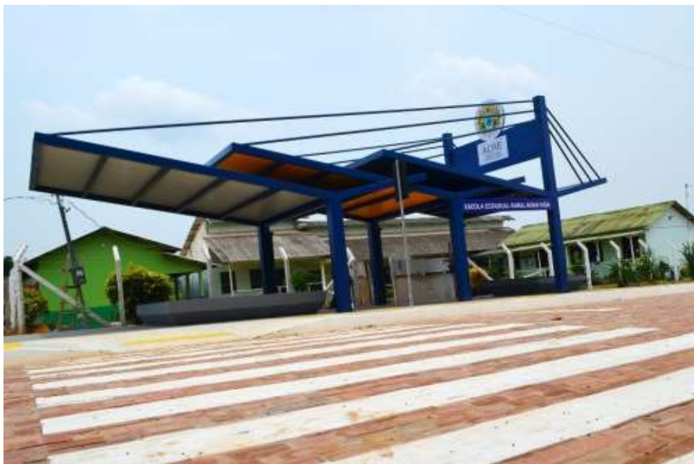
Figura 15 - Frente da Escola Nova Vida, mesma instituição em que foi aplicado o produto. Fonte: Mardilson Gomes.
