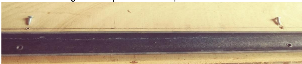
Fig. P20: Fixação da canaleta à prancha de madeira
