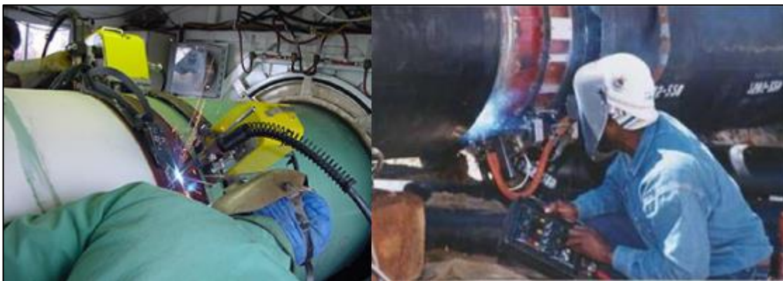
Figura 9: monitoramento visual de soldagem de tubulação através de visão infravermelha
