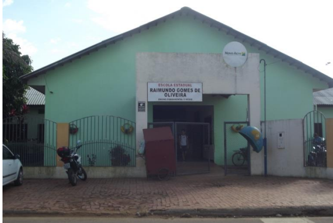
Figura 1 - Fachada da Escola Estadual Raimundo Gomes de Oliveira - Fonte autor.
