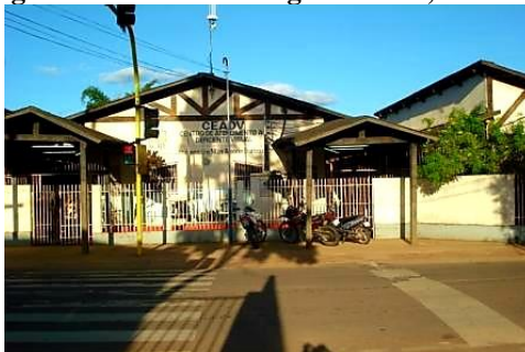
Figura 2: Prédio do antigo CEADV, em 1995.
