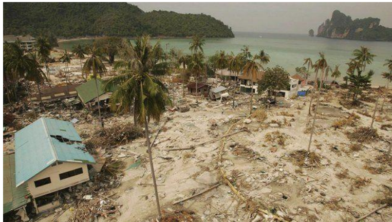
Figura 21: Destruição provocada pelo tsunami em Ko Phi Phi Tailândia
