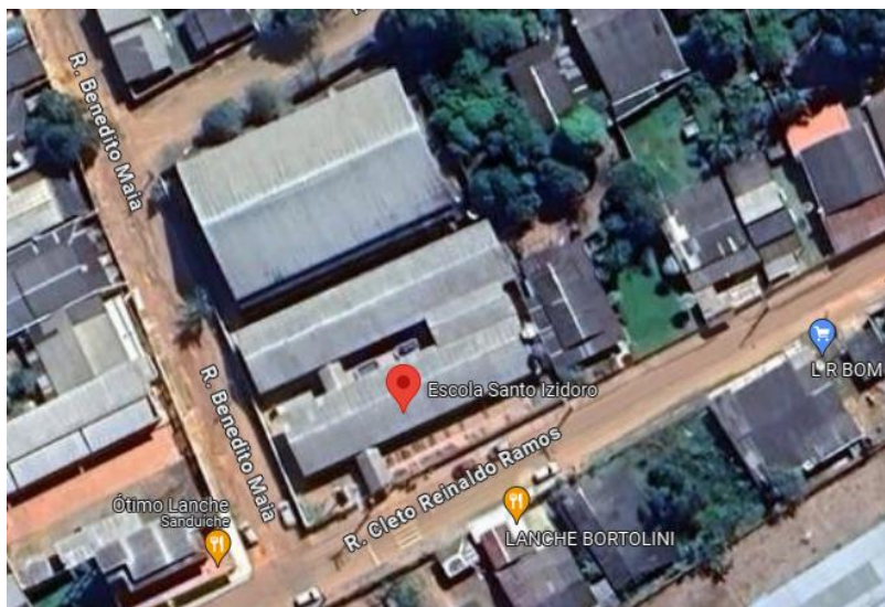
Figura 01 - Visão de satélite da Escola de Ensino Fundamental e Médio Santo
