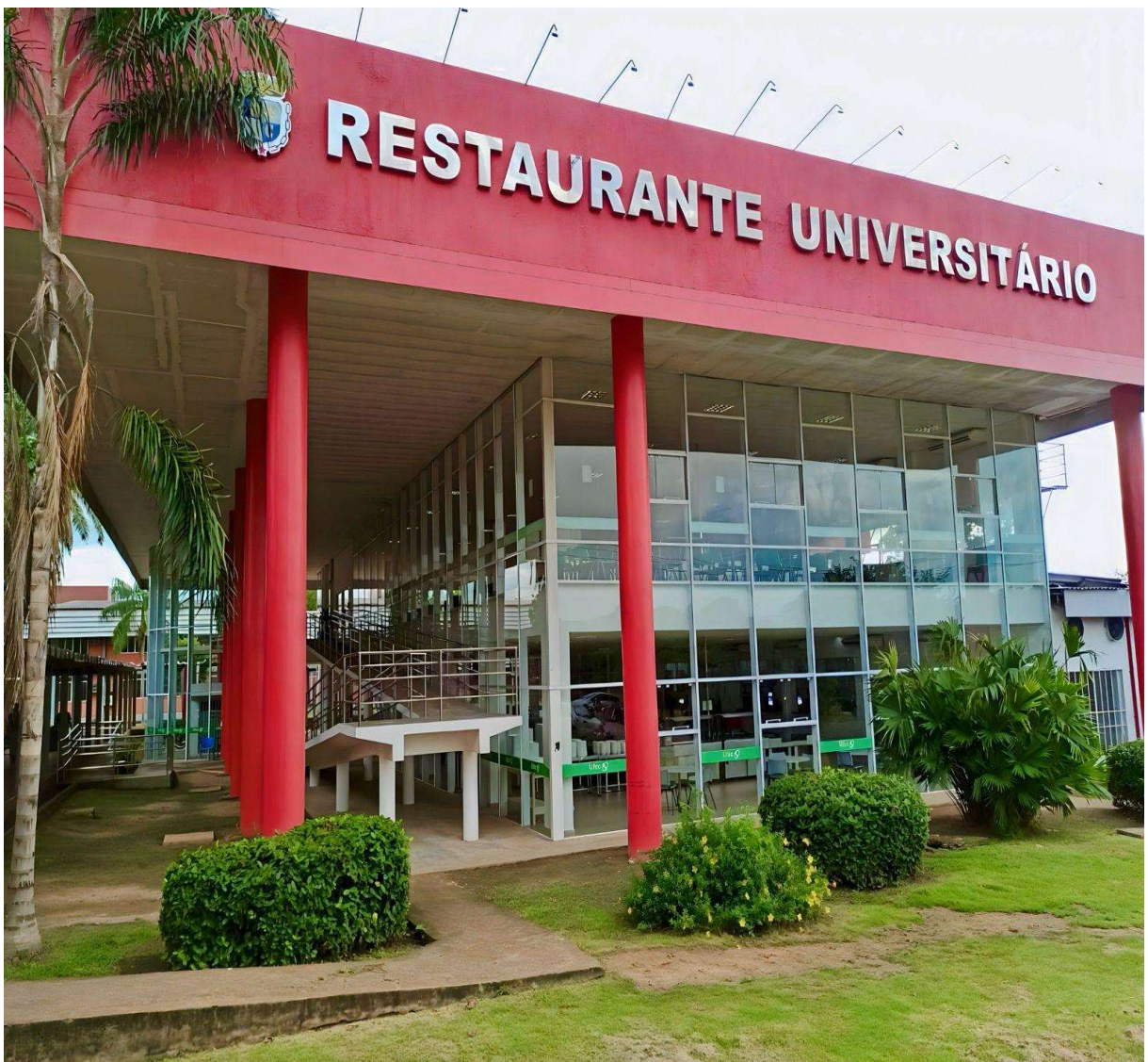
Figura 1: O Restaurante Universitário após a reforma
