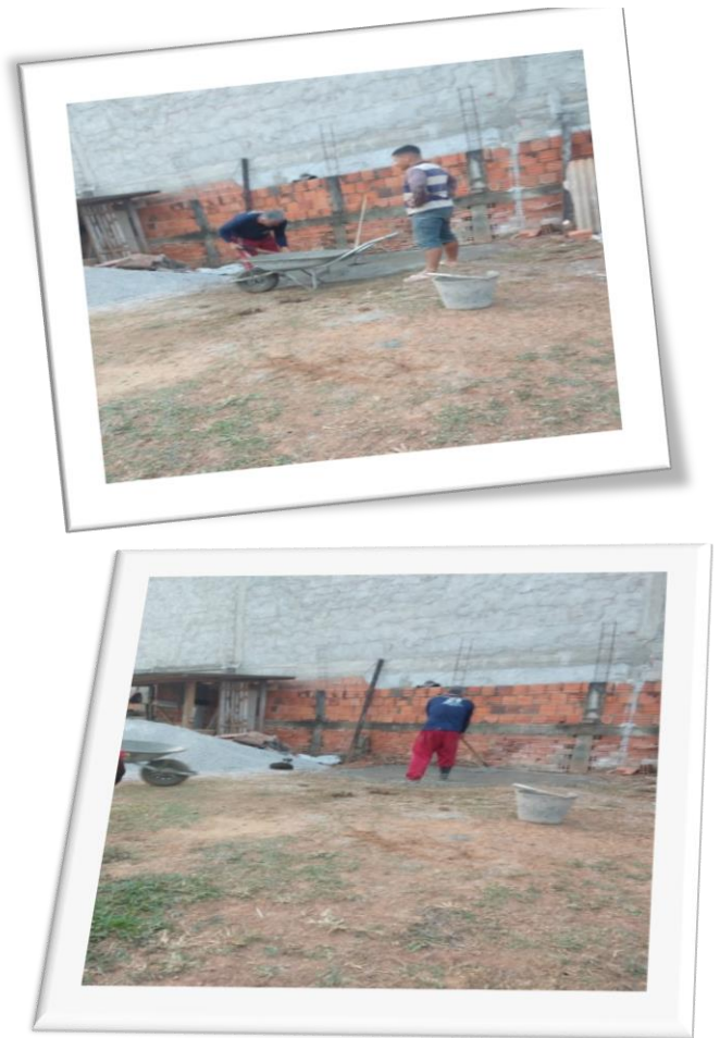
Figura 21: Pedreiro e servente na construção
