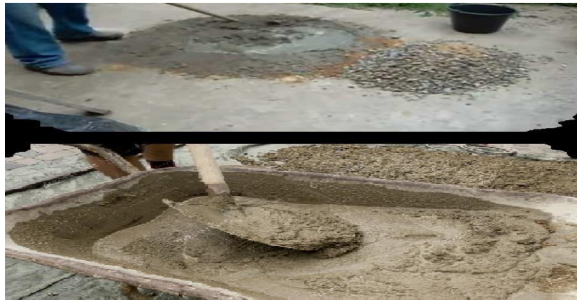
Figura 25: Misturando as dosagens para preparar a massa usada na obra
