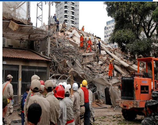
Figura 7 – Edifício Real Class em 2011 após desabamento.
