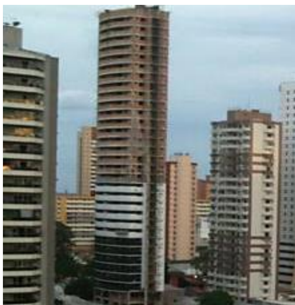
Figura 6 – Edifício Real Class em dezembro de 2010.
