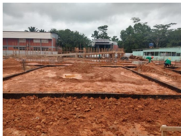
Figura 4 – Baldrame e rampa da construção Fonte: Os autores, 2019.
