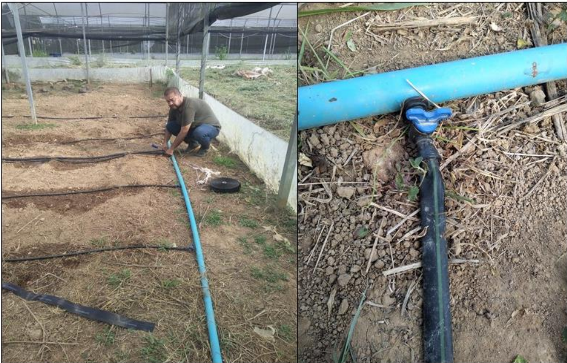
Figura 8 – Instalação do sistema de irrigação por gotejamento na área de experimentação agrícola, Universidade Federal do Acre, Rio Branco, maio de 2020.
