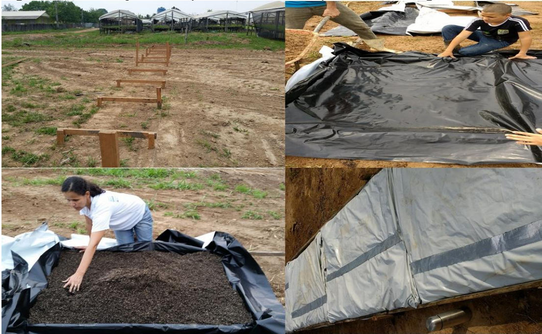
Figura 5 – Instalação do experimento em campo, com montagem dos slabs
