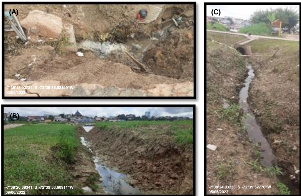
FIGURA 12. Pontos de vazão regular proveniente do esgotamento urbano identificados no bairro do Miritizal
