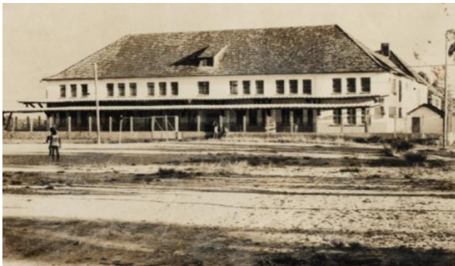
FIGURA 13 – PRÉDIO ESCOLAR: AMPLIAÇÃO (1978)
