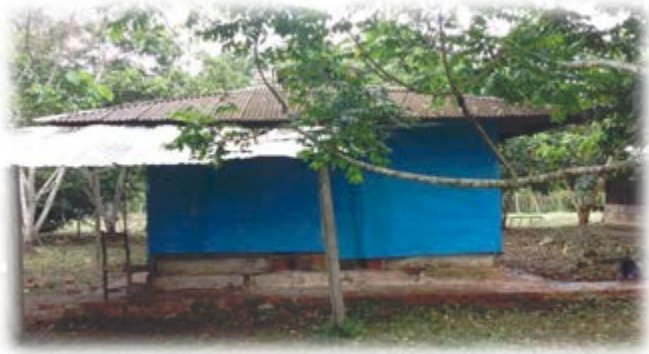
Apêndice A – Galpão experimental em vazio sanitário.
