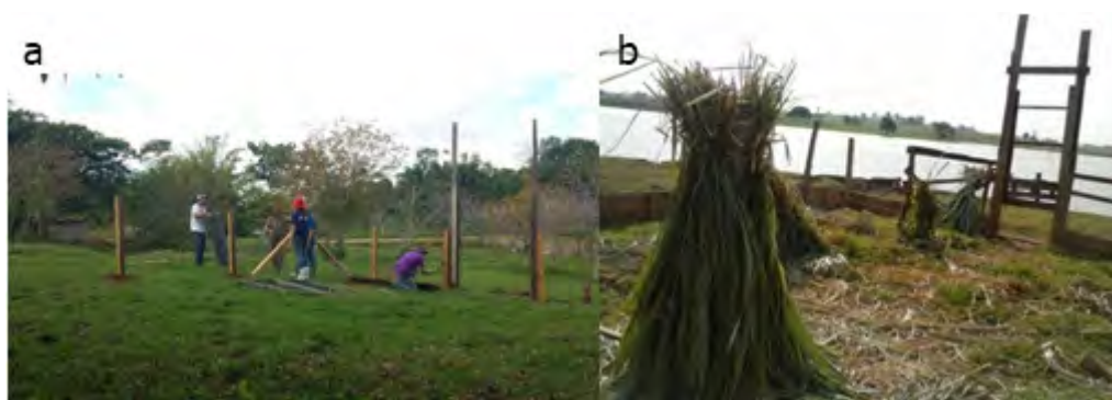
Figura 2. Construção das cevas: utilizando-se madeira e tela de arame, com dimensões de 9x12m 2 (a); Sistema de acionamento da armadilha (b).
