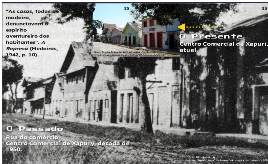
Figura 16: Centro comercial de Xapuri, no passado e no presente.
