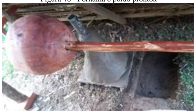
Figura 46 - Fornalha e porão prontos.
