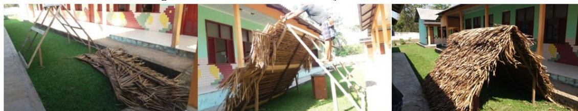
Figura 43 - Conclusão da construção do defumador.
