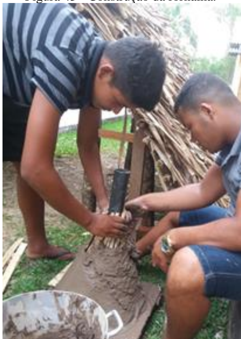
Figura 45 - Construção da fornalha.
