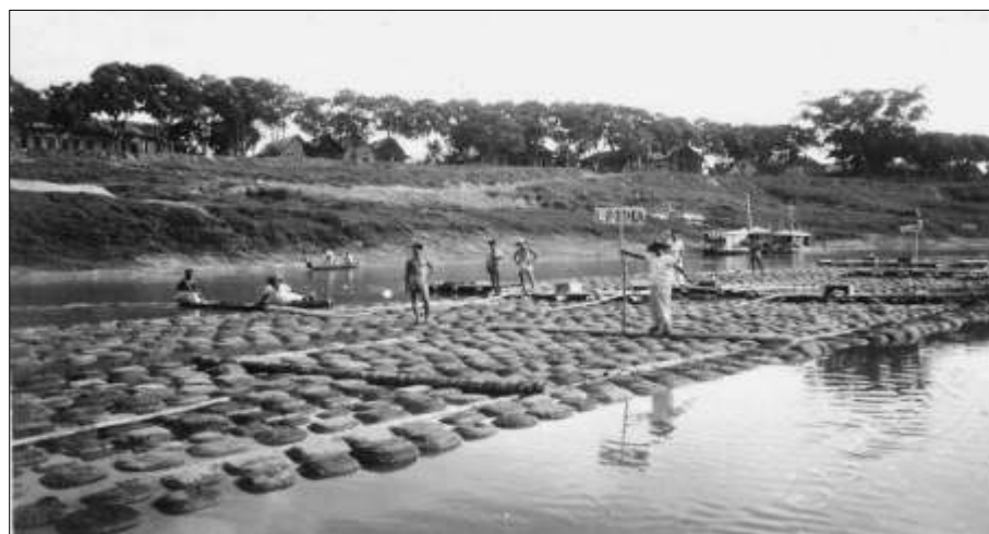
Figura 10- Balsa transportando borracha no rio Acre
