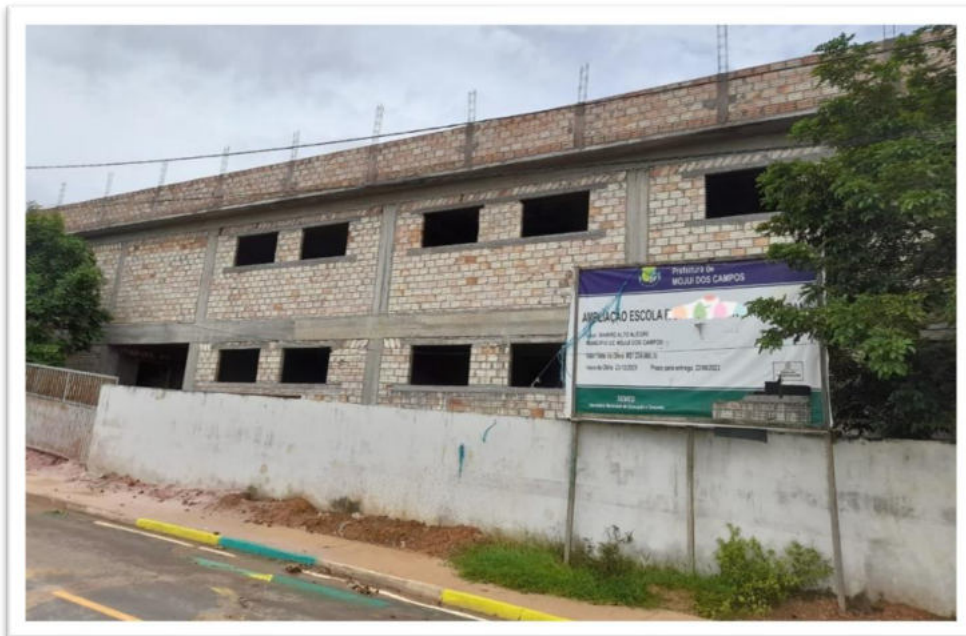
Figura 11 – Novas instalações da escola.
