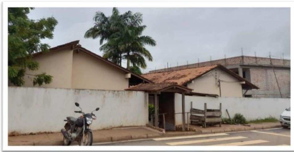
Figura 10 – Fachada da escola municipal locus da pesquisa.
